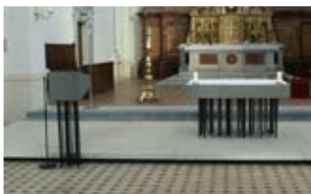
20 Kostol sv. Jozefa v Grazi – levitujúce kamenné platne na subtilných kovových podperách, 2008. Zdroj: https://www.kaindlbauer.com/projects/altarraumgestaltung-pfarre-st-josef-graz/
